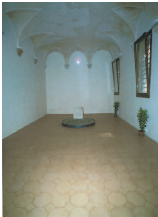
fig. 23. Veduta della saletta rinascimentale dopo il restauro.
