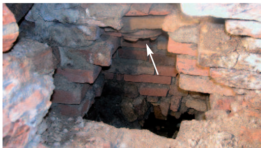
fig. 27. L'interno della fossa da butto riempito fino oltre l'attacco di volta.
