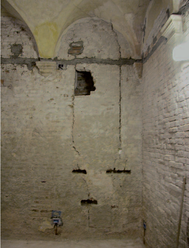
fig. 25. Le tracce di un vano finestra sulla parete est della sala voltata al piano terra.
