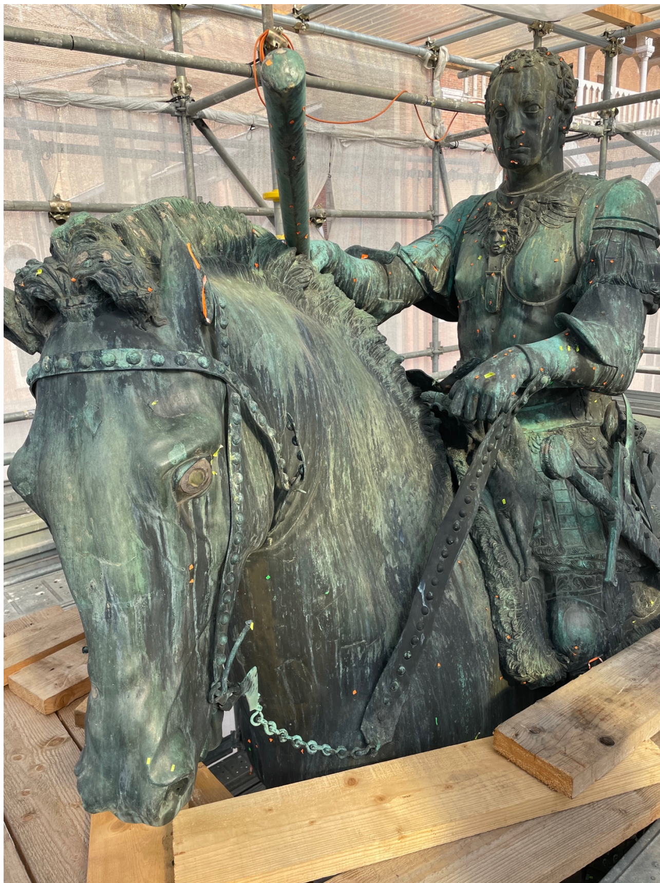
Monumento al Gattamelata: cantiere della fase diagnostica 2023-2024
