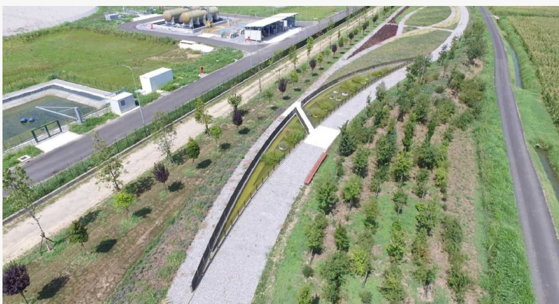
Figure 3-4-5-6 – Immagini dell'intervento di mitigazione in rapporto alla centrale e al paesaggio circostante
